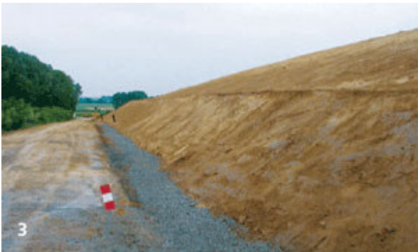
3 Stato della scarpata a fine costruzione
