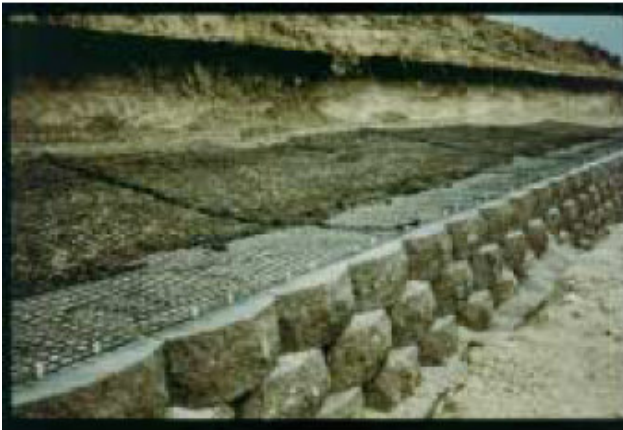
Fig.9 Terra rinforzata con paramento in blocchetti di calcestruzzo
