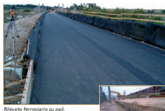
Rilevato ferroviario su pali,
